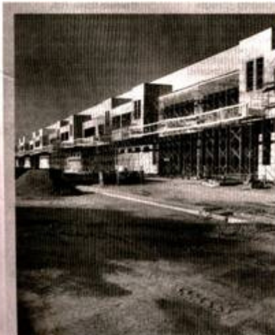
QUASE PRONTO Galpão da GR Properties, no Medeiros: novo condomínio
